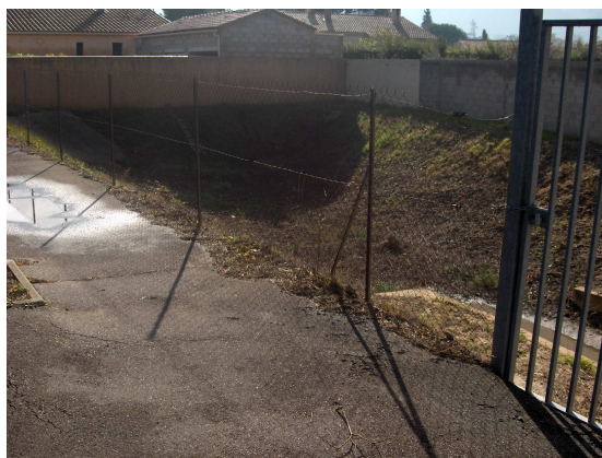
Bassin de rétention – Quartier Croix Blanche – Nouveau Village
