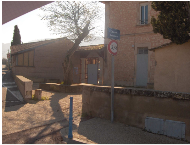
Ecole de Maubec – Nouveau village
